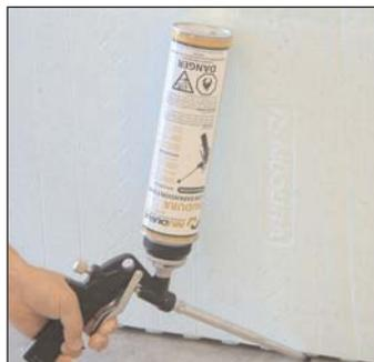
**INSTALLATION :** Fixer le pistolet au contenant (ne pas serrer avec excès) puis bien agiter pendant 30 secondes.
